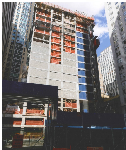
2013年4月22日,第一期项目建设中
